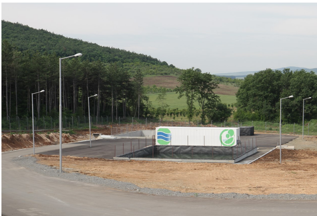
Снимка № 4. Модулно пречиствателно съоръжение за инфилтрат
