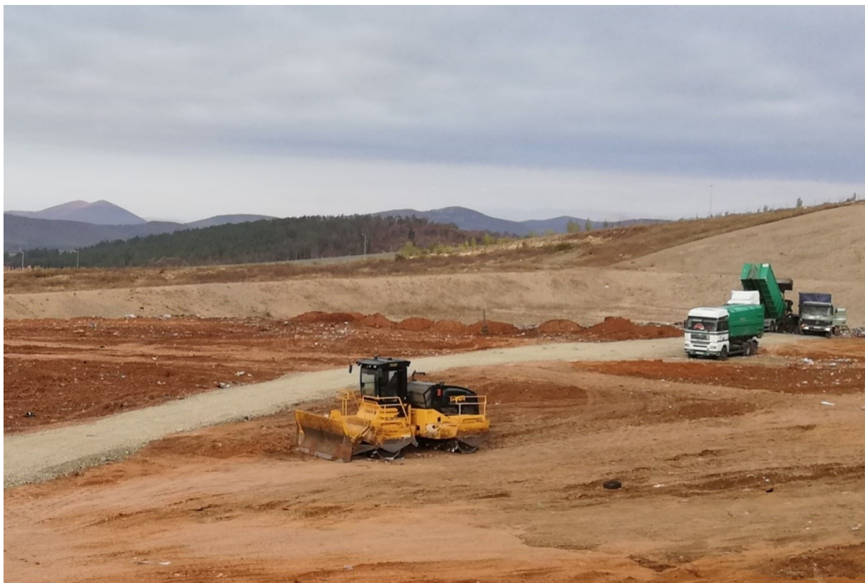
Снимка № 1. Клетка 1 за депониране на неопасни отпадъци
